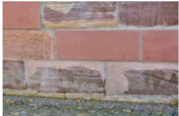
Vergleichen Sie: Der linke Teil der mit Naturstein verkleideten Mauer wurde fast bündig verfugt; die Fugen werden dominanter Teil der Mauer, die Steine verkommen zum „flachen“ Dekor. Der rechte Teil der Mauer behält durch die dezente Verfugung seine plastische, lebendige Wirkung.
