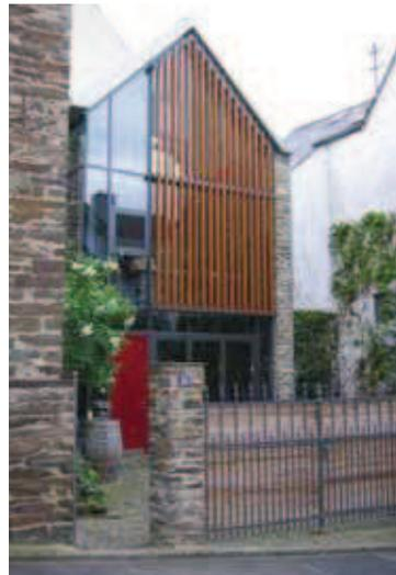
Ein vorbildliches Beispiel von der Mosel: Das alte aus Bruchsteinen gemauerte Wohngebäude wurde im Hof durch einen zeitgemäßen Neubau ergänzt, der in seiner **Form und Höhe dem Altbau entspricht**. Die moderne, offene (Isolier-) Glasfassade nutzt die Möglichkeiten heutiger Baustoffe aus und trägt dem Umstand Rechnung, dass im eng bebauten Ortskern helle Räume nur durch **große Fenster** zu erreichen sind.
