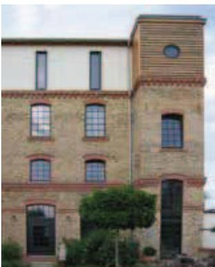
Wird ein historisches Gebäude in der Höhe erweitert, ist besondere Sorgfalt erforderlich. Im abgebildeten Beispiel wurde ein gründerzeitlicher Gewerbebau zum Wohngebäude umgenutzt und aufgestockt. Die Erweiterung ist durch die helle Putzfassade deutlich von der Backsteinfassade abgesetzt und lässt dadurch die **ursprünglichen Proportionen des Gebäudes sichtbar**. Die Fensterschlitze greifen die Fensterachsen auf, verwenden jedoch eine eigene, moderne Formensprache.
